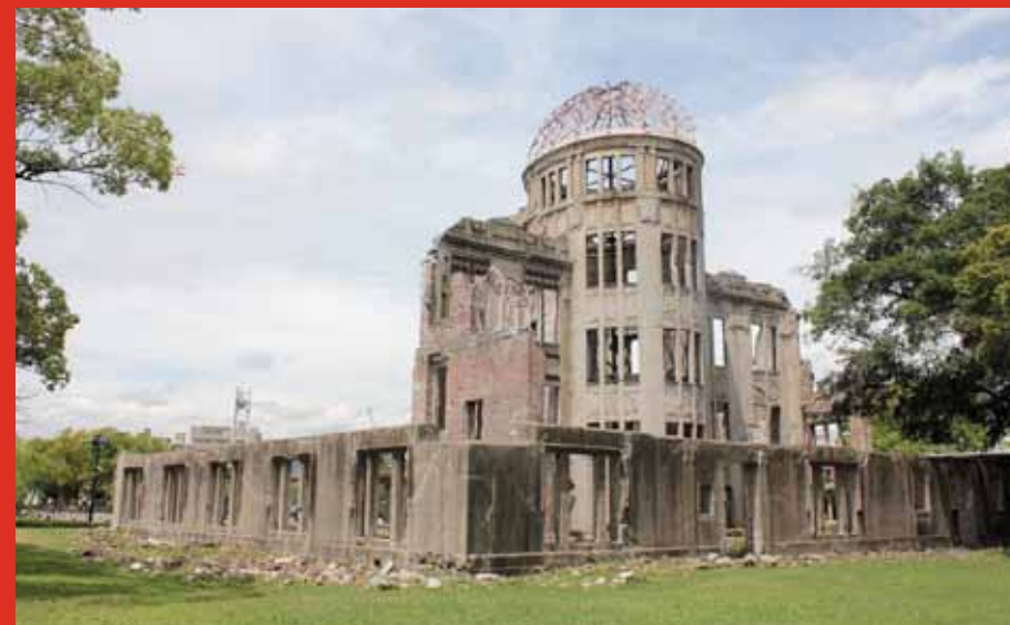
Hiroshima a été entièrement reconstruite, seul le bâtiment ci-dessus a été conservé tel quel.
