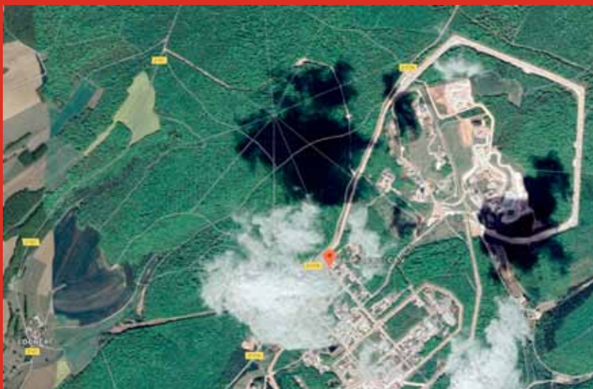
Vue aérienne du Centre du CEA de Valduc
